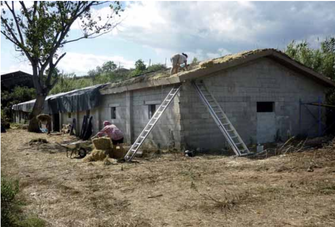
Treballs d'aïllament i condicionament de Can Tonal
