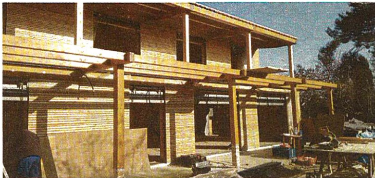
Construcció d'habitatge amb estàndards passivhaus en fusta i cotó reciclat. Classificació energètica A+.
