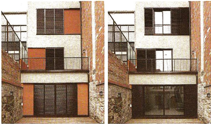
Rehabilitació energètica integral d'edifici a Sant Andreu (BCN). Classificació energètica A.
