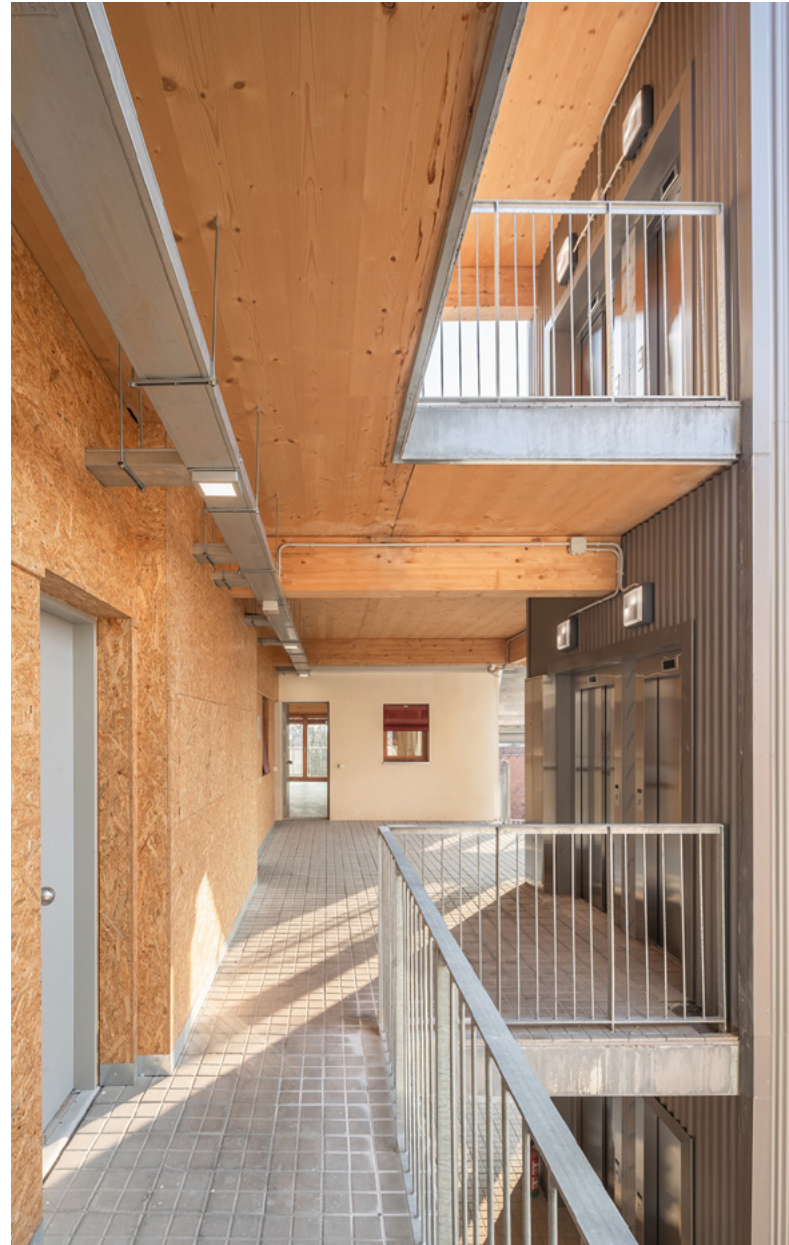
Espai comú semiexterior a l'edifici cooperatiu Cirerers | Joan Guillamat
